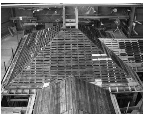
修復作業中の経蔵
